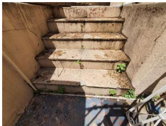
««« 9 placas de Pedra Lioz na escadaria de acesso e soleira da sala/cozinha comunitária Casa 01 – Vila Sal [Fotos: Marcos Tognon]
